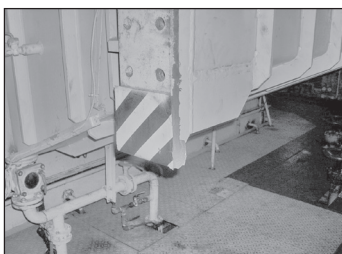
衝突防止の緩衝材
