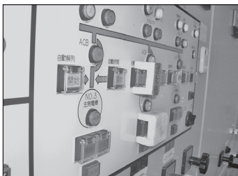
エラー防止の手作りカバー (発泡スチロール製)
