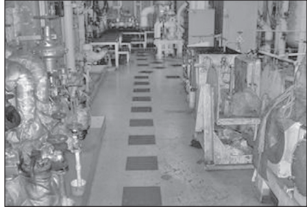
図3-2a 主要通路（機関室）
